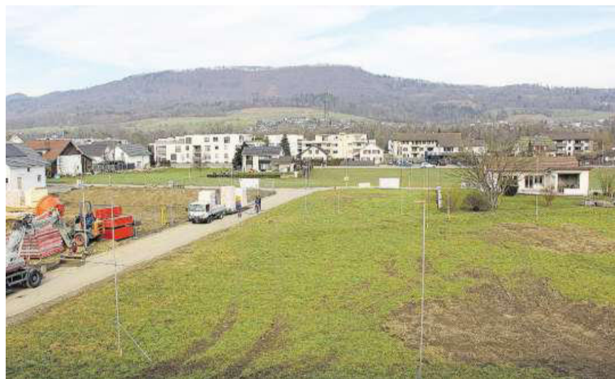
Im Rapperswiler Breechli wird wacker gebaut: Die Bauprofile deuten die zwölf Reiheneinfamilienhäuser an.
